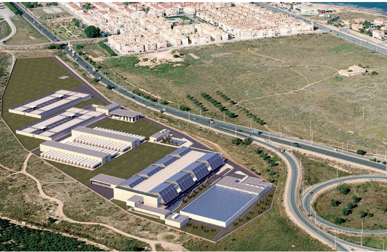
Desaladora de Torrevejea. La mayor de Europa.
